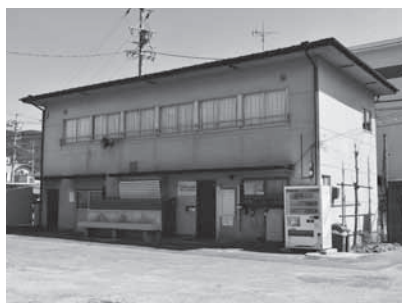
改築が予定されている、 総合運動場管理棟
